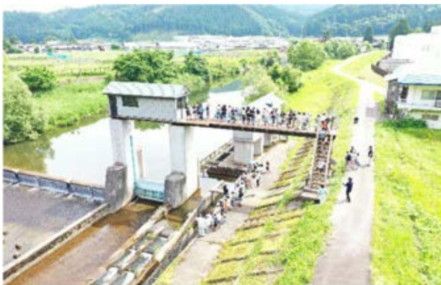
新一の堰頭首工見学
