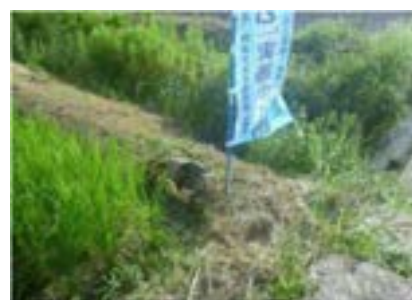
田んぼダム(せき板・のぼり設置)
