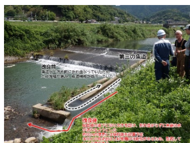
魚道の改築の発案及び工事の監修
