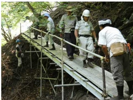
登山道の鉄骨化作業
