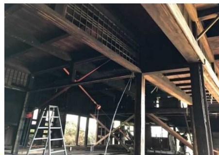
急斜面に建つ古民家の軸組直し
