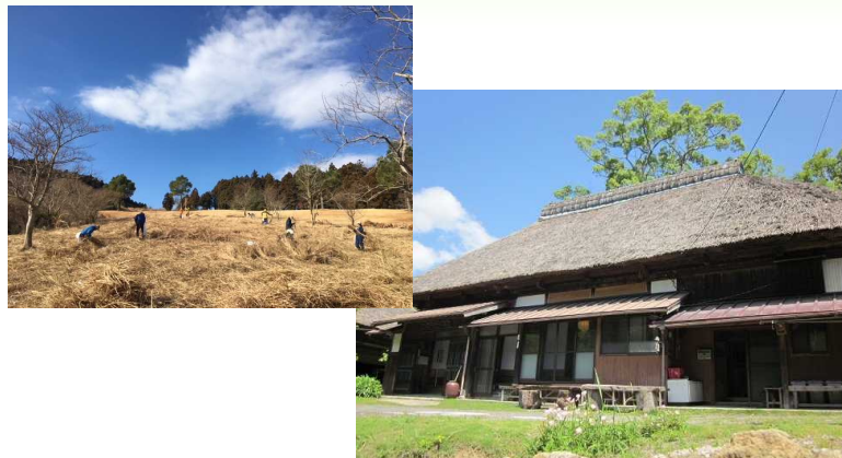
茅を刈り、宿泊施設の茅葺屋根補修
