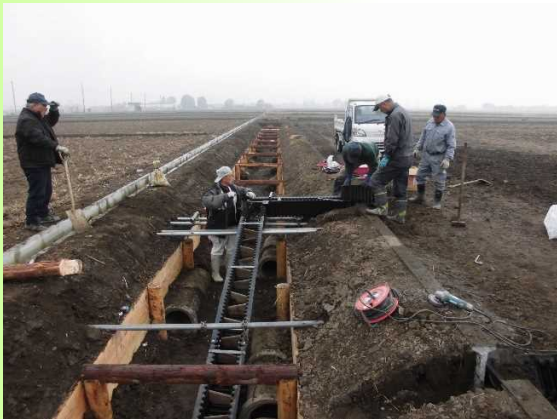
水田魚道の設置風景
