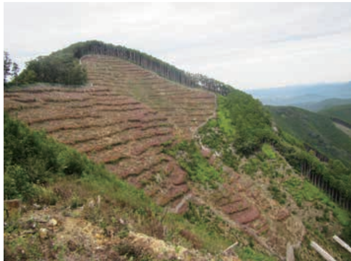
植栽完了現場写真
