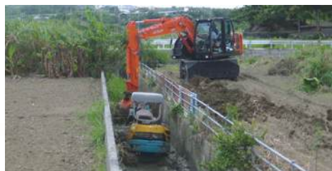
水路の土砂上げ作業
