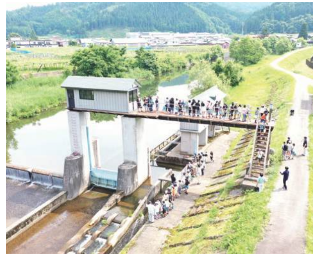
新一の堰頭首見見学
