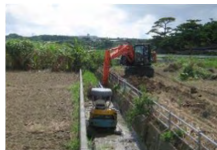
水路の土砂上げ作業
