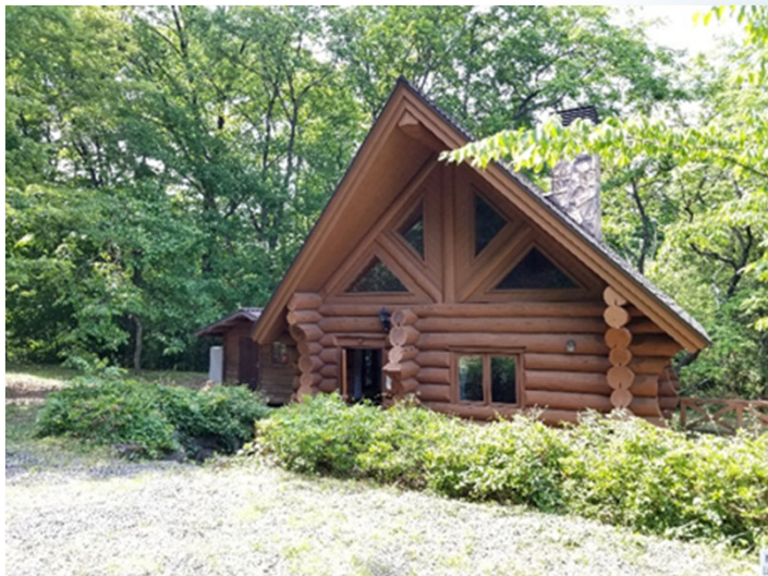
空き家を改修した宿泊施設
