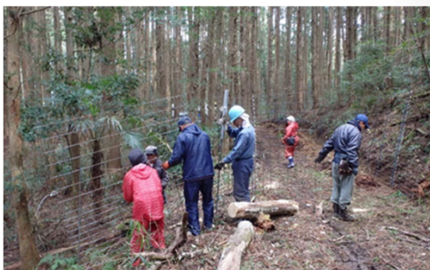
鳥獣被害防止柵設置の様子
